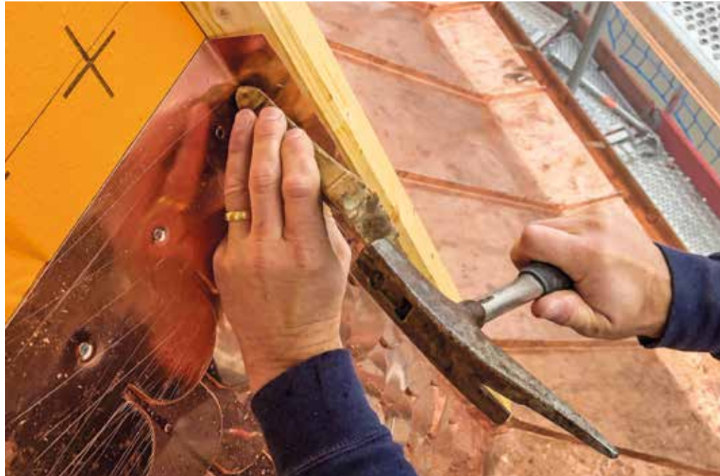
Das Doppelfalzdach ist echte Handwerksarbeit. Übergang vom Doppelstehfalzdach zur Schindelbanddeckung im Turmbereich.
