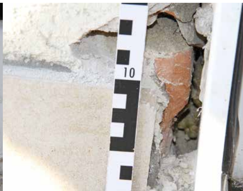
Bild 3: Die Nassfalzentwässerungsöffnung liegt 10,0mm über Oberkante keramischen Belag, eine vorgelegte Rigolrinne fehlt gänzlich.
