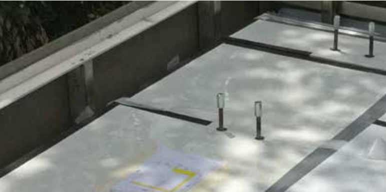
Verlegung der SF-Vakuumdämmung mit vorbereiteten Bereichen für Auslässe wie Gullys, etc.
