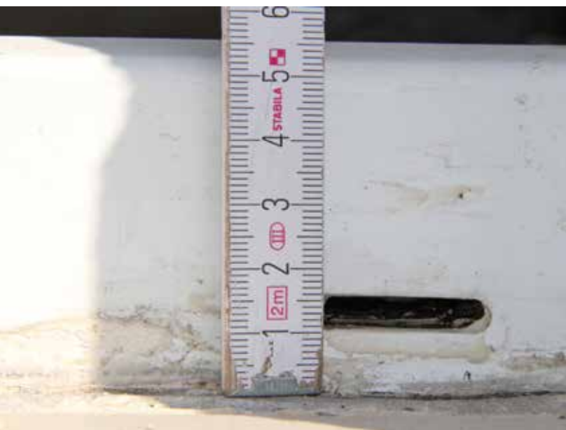
Bild 3: Die Nassfalzentwässerungsöffnung liegt 10,0mm über Oberkante keramischen Belag, eine vorgelegte Rigolrinne fehlt gänzlich.
