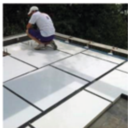
Einsatzbezogene Vakuumdämmpaneele für Flachdach, Balkon und Terrasse
