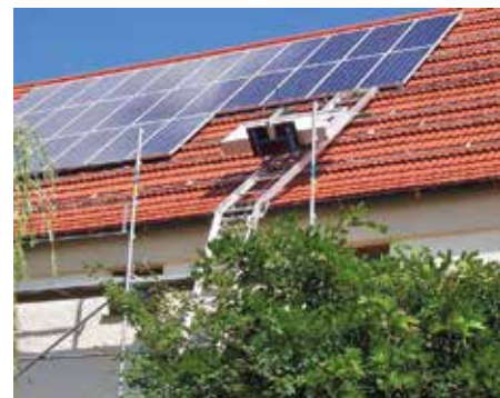
Bild unten: Der „GEDA Solaraufzug 250“ transportiert schonend und sicher.
