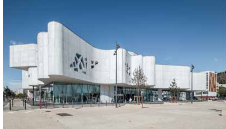
Das Obergeschoss der Mediathek krägt mit einer wellenartigen, weitgehend geschlossenen Fassade aus Weißbeton aus.
