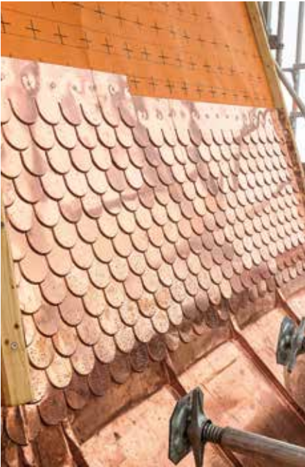
Das Doppelfalzdach ist echte Handwerksarbeit. Übergang vom Doppelstehfalzdach zur Schindelbanddeckung im Turmbereich.
