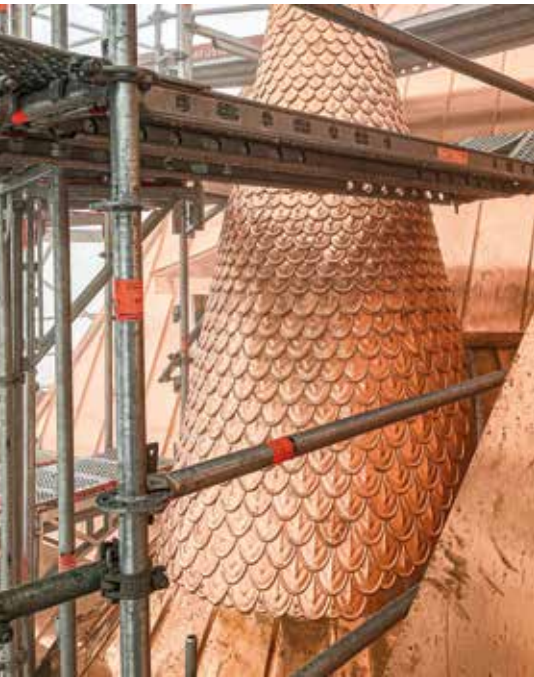
Einzelschindel am konischen Kegelturm.
