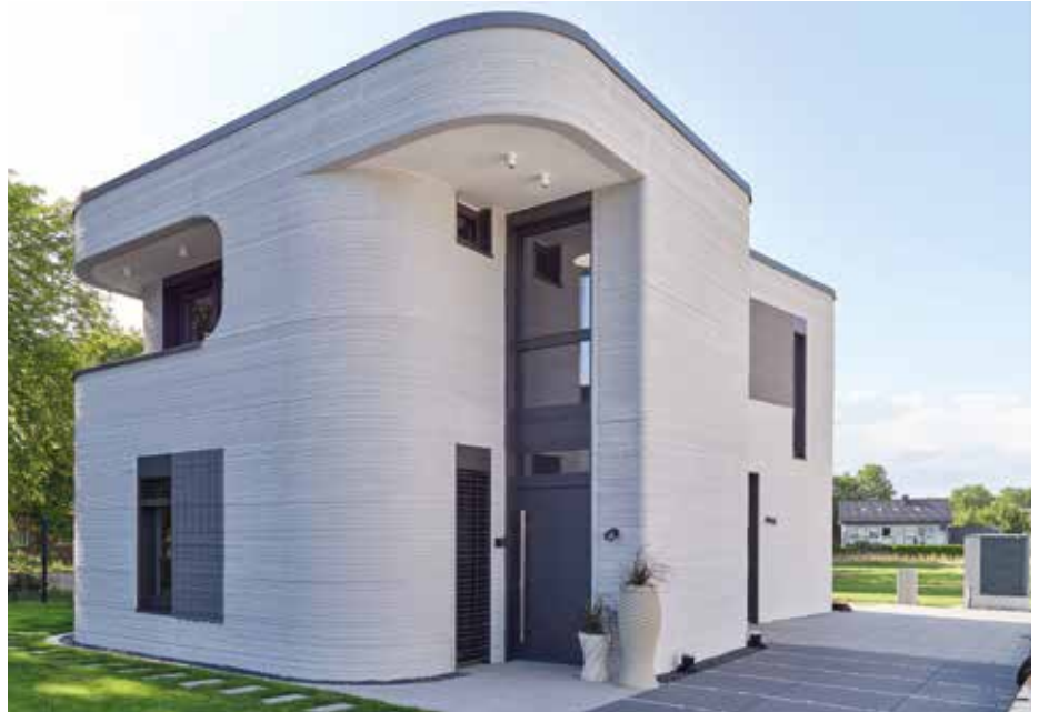
Das zweigeschossige Einfamilienhaus mit rund 160 Quadratmetern Wohnfläche ist das erste seiner Art in Deutschland. Die Metallprofile wurden mit dem Blechkaltkleber Enkolit® befestigt. | Foto: © PERI AG / https://peri3dconstruction.com
