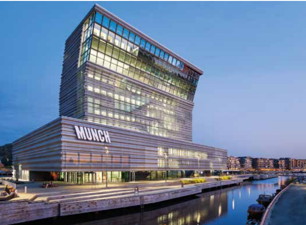
Mit geknicktem Kopf neigt sich der Baukörper in Richtung der Innenstadt und seine Fassade verläuft in leichten Wellen, die von perforiertem Aluminium geformt werden und irisierende Effekte erzeugen. | Foto: © Einar Aslaksen
