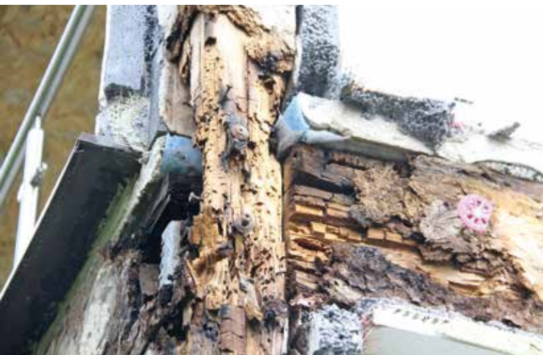
Jede weitere Öffnung des WDVS offenbart den massiven Folgeschaden, die Tragkonstruktion ist dem Grunde nach völlig zerstört.
