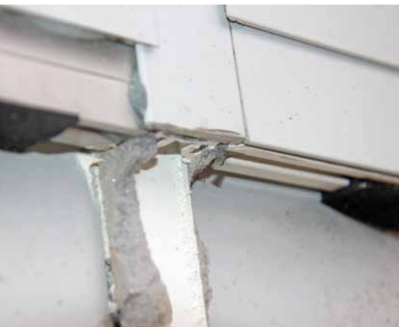
Bild links: Eine hinterlaufsichere Abdichtung ist mit gewöhnlichen Mitteln kaum herstellbar. Bild rechts: Die Störung am Anschlussgrund für die Abdichtung ist deutlich.
