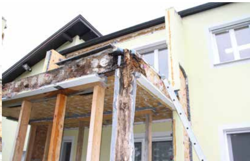
Jede weitere Öffnung des WDVS offenbart den massiven Folgeschaden, die Tragkonstruktion ist dem Grunde nach völlig zerstört.
