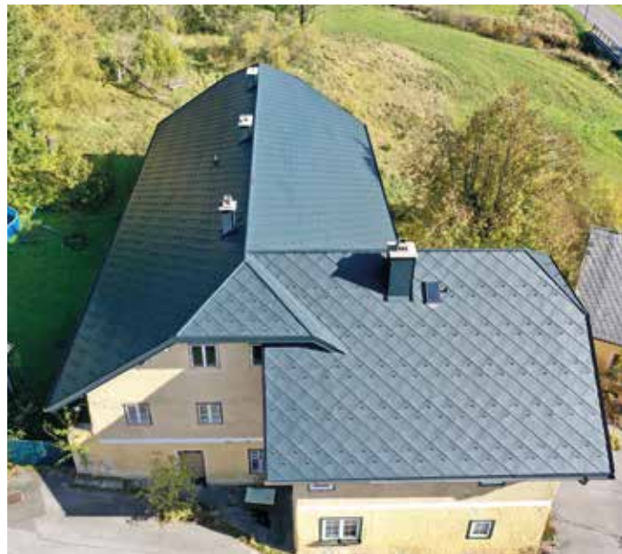
Aus statischen und anderen funktionalen Gründen: das neue Dach aus Aluminium-Schindeln – ein Produkt der Firma haushaut.
