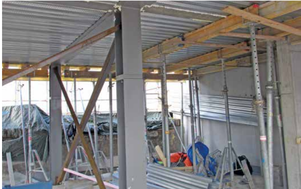
Die Auflagerung der Cofrastra 70 auf den verbreiterten Unterflansch ermöglicht die deckengleiche Integration des Stahlträgers.
