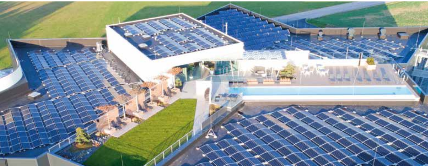
Grüne Oase als Lebensraum für Mensch und Tier sowie kostenlose Energie direkt vom Dach: Das kann nur ein Flachdach!
