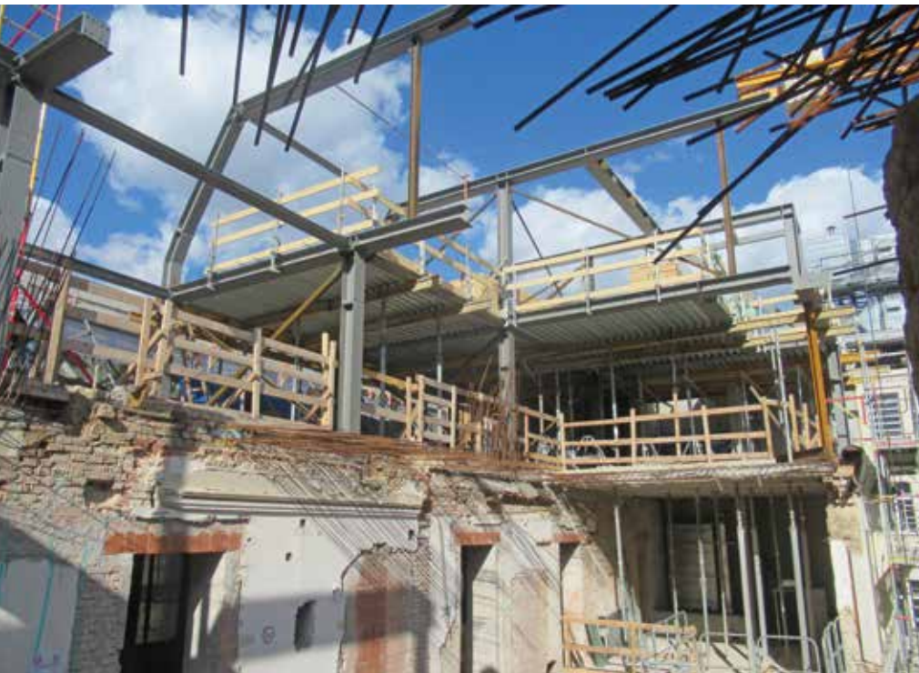
Komplexes Bauvorhaben in luftiger Höhe: Cofrastra 70 Verbunddecke über 5,20m mit temporärer Unterstüztung während der Betonage.
