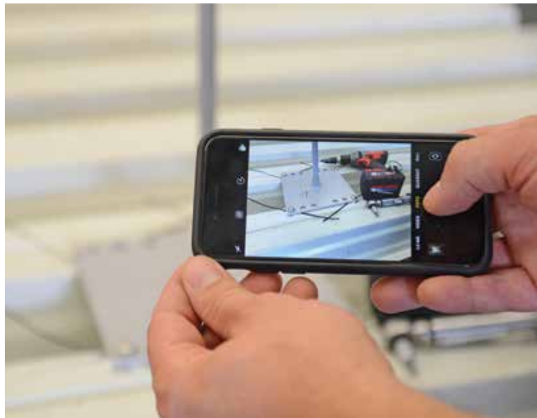
Bild links: Ein Beispiel für montierte Seilsysteme/Anschlageinrichtungen. Bild rechts: Beispielhaftes Doku-Foto: Festgehalten wird die Einbausituation jeder nummerierten AE inklusive Werkzeuge.
