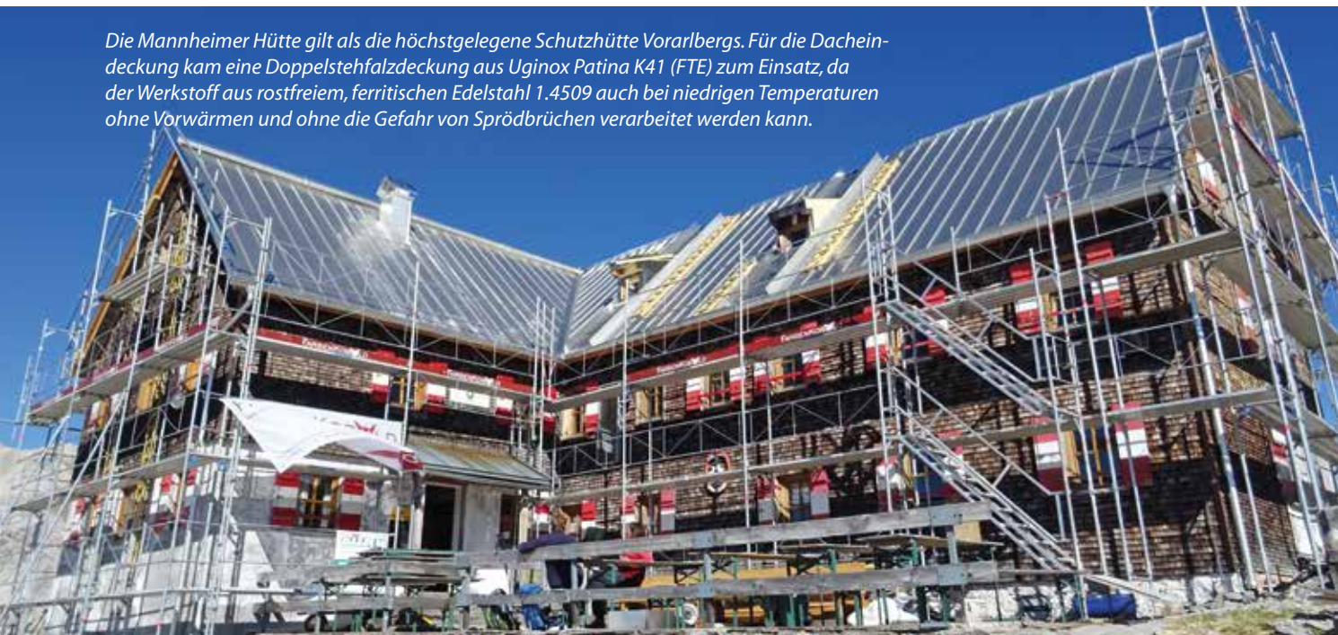
Fotos: © Küng Spenglerei & Dachdeckerei GmbH (2)
