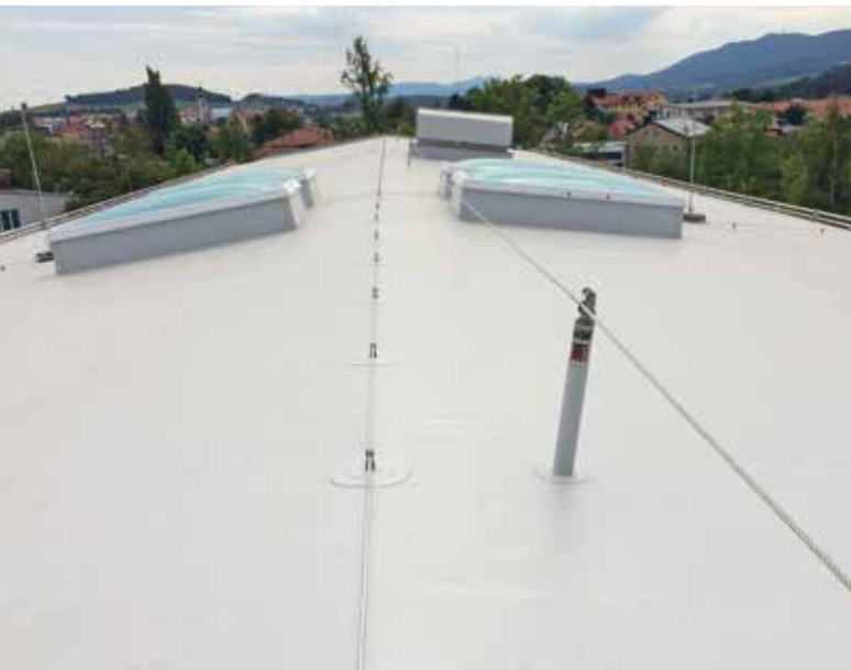
Bild links: Ein Beispiel für montierte Seilsysteme/Anschlageinrichtungen. Bild rechts: Beispielhaftes Doku-Foto: Festgehalten wird die Einbausituation jeder nummerierten AE inklusive Werkzeuge.
