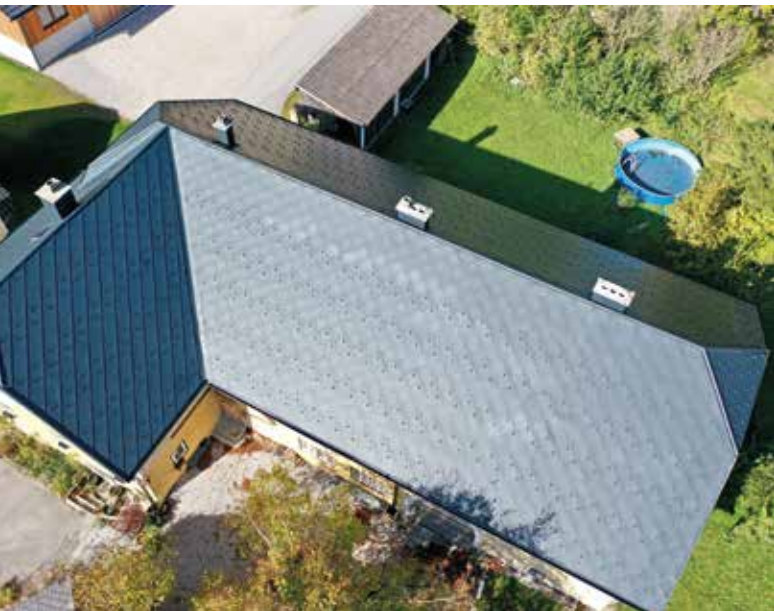
Aus statischen und anderen funktionalen Gründen: das neue Dach aus Aluminium-Schindeln – ein Produkt der Firma haushaut.
