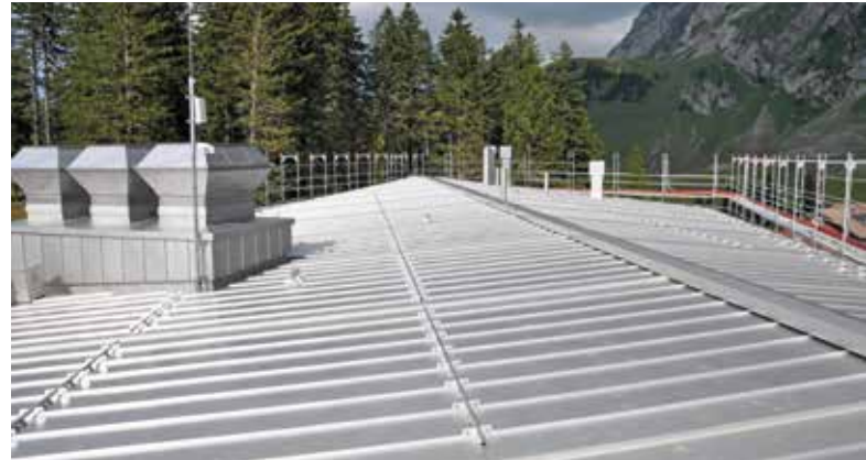
Bild oben: Das Hoteldach: Doppelfalztechnik, Aufbauten, Schneefanganlagen, First. | Bild unten: Die sanierte Talstation in Roofinox Pearl.
