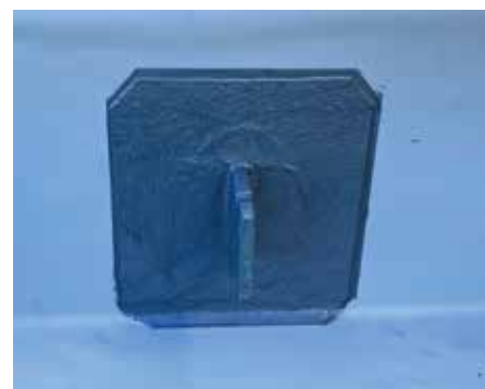
6. Perfektes Ergebnis: Die fertige Enkopur-Flüssigkunststoff-Abdichtung.
