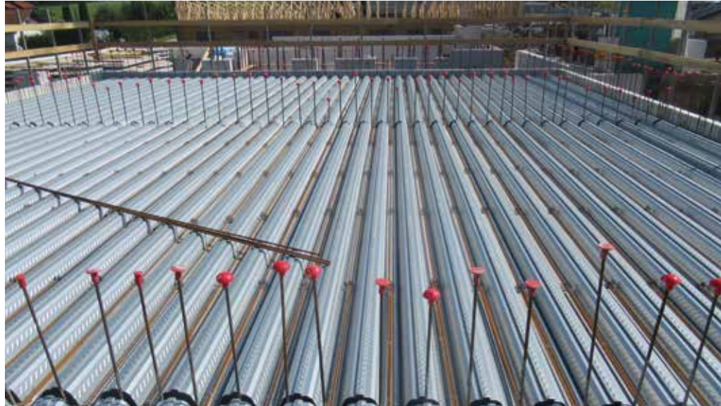
Cofraplus® 80 ermöglicht im Bauzustand Spannweiten von bis zu 4,50 m ohne Unterstützung und mehr als 6,50 m mit temporärer Unterstützung. Es kann vor Ort meist schnell und einfach, ohne Kraneinsatz, montiert und eingebaut werden.
