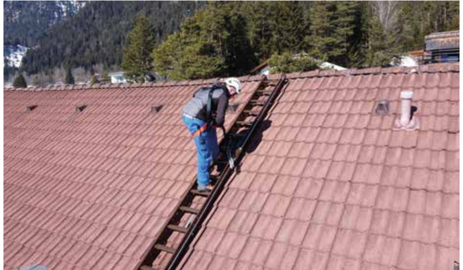
Die neue OBS-Sicherheitsdachleiter der FRATO Betriebs GmbH mit integriertem Anschlagpunkt steht für das gefahrenreduzierte Begehen und die Personensicherung am Dach.
