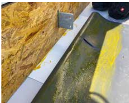
1. Vorbereitung der Unterkonstruktion und Auftrag des Folienklebers.
