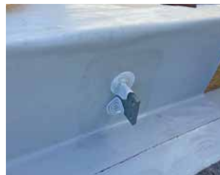
3. Vorbereitung der Unterkonstruktion und Auftrag des Folienklebers.
