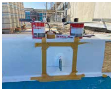
5. Anpassung des großflächigen Polyflexvlies-Flansch.
