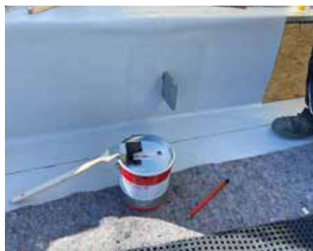
2. Anschliff der Folienbahn mit 40er Korn und Auftrag des Enke-Universalprimer 2K.
