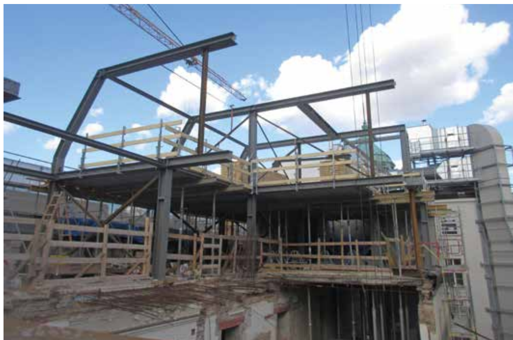
Cofraplus® 80 ist flexibler handzuhaben als herkömmliche Fertigbeton-Elemente. Es kann noch vor Ort projektbezogen angepasst werden und so kurzfristigen Entwurfsänderungen und neuen Anforderungen folgen.
