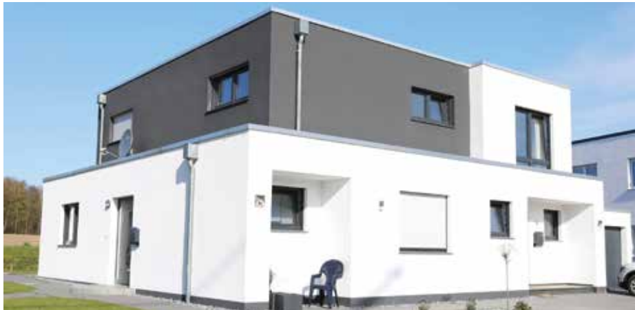
Staffelgeschosse sind eine elegante Alternative, den Wohnraum zu erweitern, wenn der örtliche Bebauungsplan ausschließlich Flachdach-Gebäude mit einem Vollgeschoss erlaubt. Fotos: © Triflex (5)
