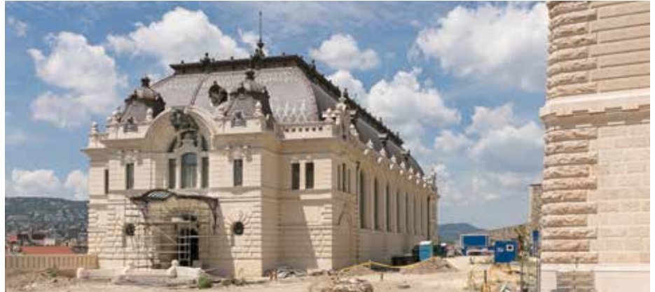
Das Gebäude war ursprünglich mit einem Mansarddach ausgestattet. Beim Neubau wurde deren obere Fläche, mit geringer Neigung mit einer Doppelstehfalzdeckung aus Kupfer ausgeführt.
