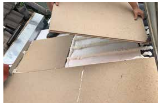
Zur Vermeidung von Wärmebrücken eignet sich Triflex BIS, eine Kombination von Abdichtungs- und Dämmsystem.
