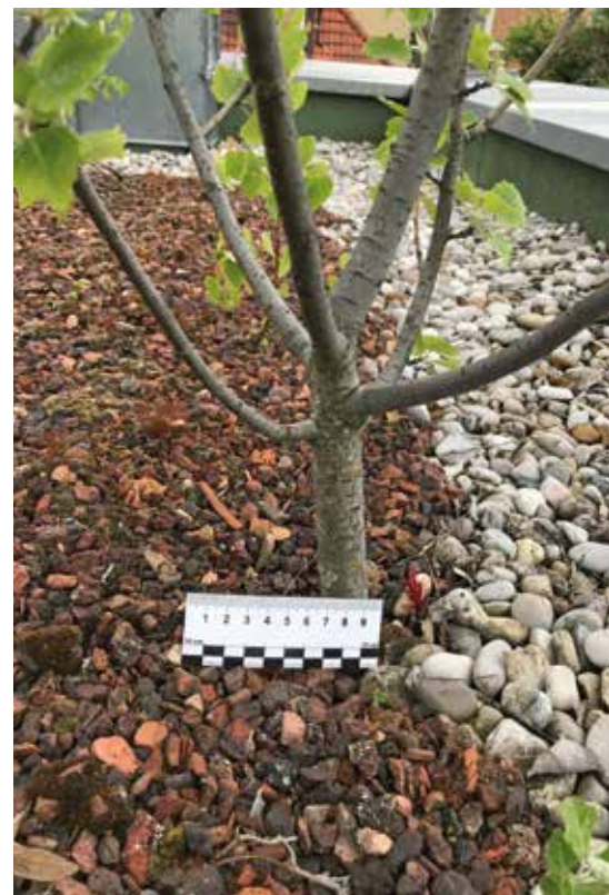
Bild 4: Unerwünschter Bewuchs bei einer extensiv begrünten Dachfläche.
