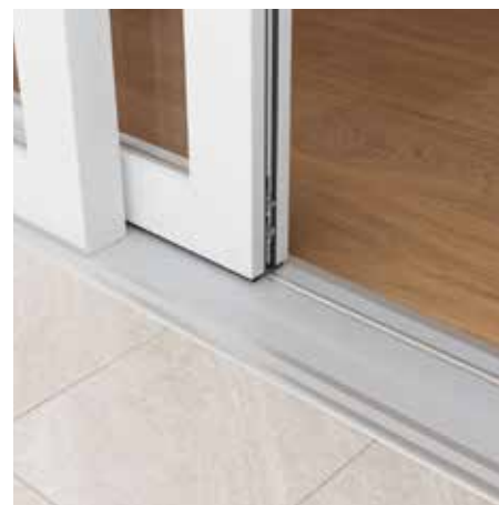
Im Sinne einer barrierefreien Lösung ist eine dauerhaft funktionsfähige Abdichtung im Übergangsbereich gefragt. Diese Anforderung erfüllt Triflex mit Systemen auf Basis von PMMA.
