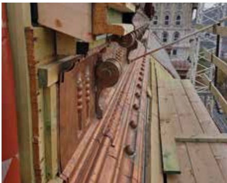
Die Ornamentelemente wurden am Dach aus geprägtem und gedruckten weichen Kupferblech hergestellt, die gezierten dünnwandigen Gussformstücke an den Fassaden wurden aus Zink produziert.
