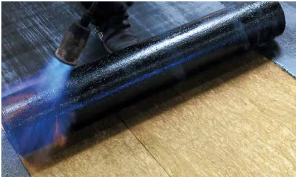
Mit „Bitrock“ bietet ROCKWOOL eine Platte mit einer innovativen, planeben geschliffenen Oberfläche im Dickenbereich von 60 bis 140 mm an. Diese sichert einen optimalen Haftverbund zwischen der Dämmung und direkt aufgeschweißten Bitumenabdichtungen.
