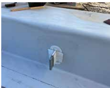
4. Anpassung der Polyflexvlies-Ummantelungen.
