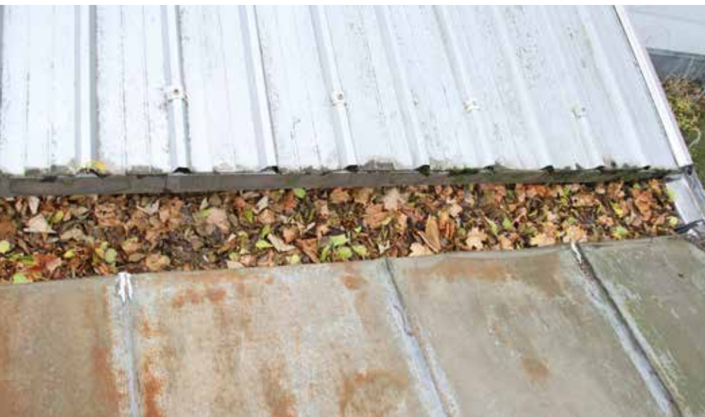
Bild 1: Alte und neue Laubablagerungen in der Dachrinne. | Bild 2: Einbaurinne samt Abflussstutzen massiv verschmutzt.
