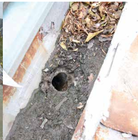
Bild 1: Alte und neue Laubablagerungen in der Dachrinne. | Bild 2: Einbaurinne samt Abflussstutzen massiv verschmutzt.
