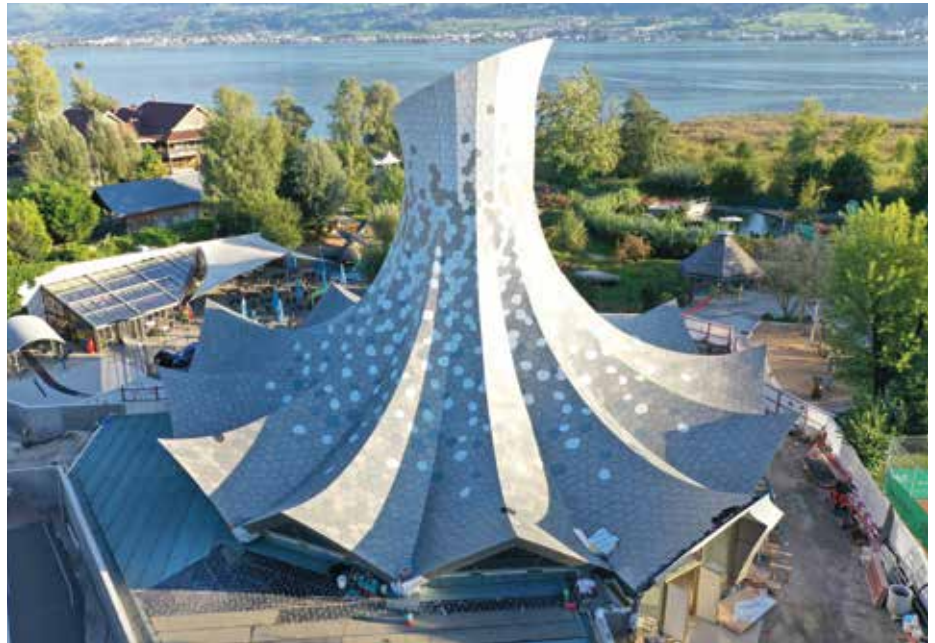
Die imposante und zauberhafte Konstruktion, ein neues Wahrzeichen in Rapperswil.
