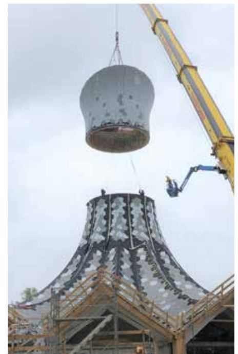
Bild 1 und 2: Anspruchsvolle Vorfabrikation der Einzelelemente und Montage der Einzelschuppen aus Zink in der Werkstatt. Bild 3: Beeindruckende Montage vor Ort in Rapperswil.
