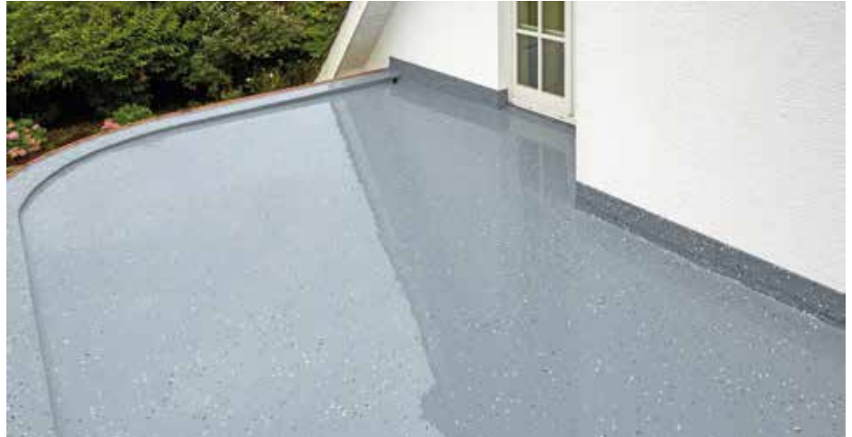
Der komplette Balkonaufbau kann an nur einem Arbeitstag fertig gestellt werden.
