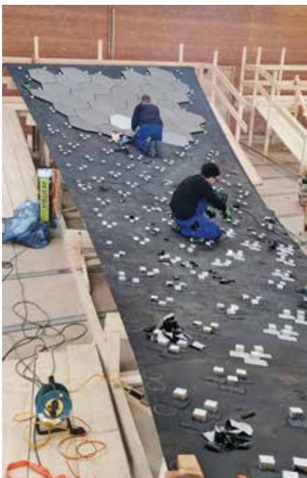
Bild 1 und 2: Anspruchsvolle Vorfabrikation der Einzelelemente und Montage der Einzelschuppen aus Zink in der Werkstatt. Bild 3: Beeindruckende Montage vor Ort in Rapperswil.
