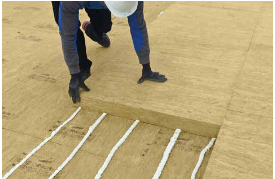
Die „Bitrock“ kann auch als oberste Dämmschicht auf Gefälledachplatten „Georock 038“ oder den Dämmplatten „Hardrock 038“ und „Hardrock 040“ verklebt werden.
