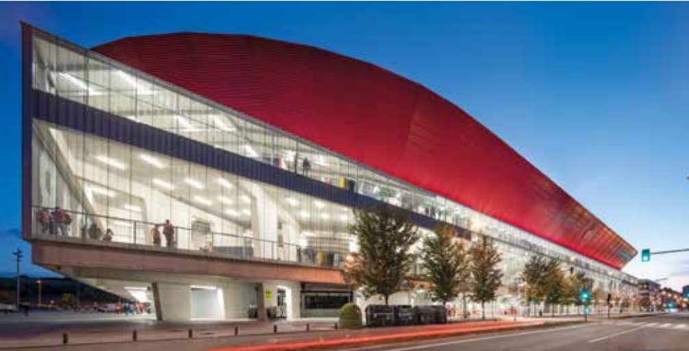
Die Überdachung des Stadions besteht aus PIR-Paneelen Ondatherm® T in 40 mm Dicke mit der Hochleistungsbeschichtung Hairexcel® in Orbite. | Fotos: © Cutillas+Tellechea (2)
