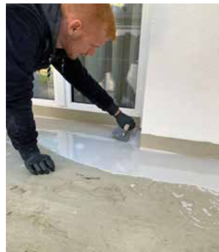
Die Verarbeiter haben die Nuttschicht mit Triflex ProFloor hergestellt. Sie wurden von Triflex-Mitarbeitern in Umgang mit dem System ausführlich geschult.
