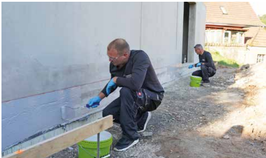
Streifenweise wird FRANKOSIL 1K Plus auf die zugespachtelten Fugen aufgetragen. Das System von FRANKEN SYSTEMS ist geeignet für einen Wasserdruck bis zu 1 bar.
