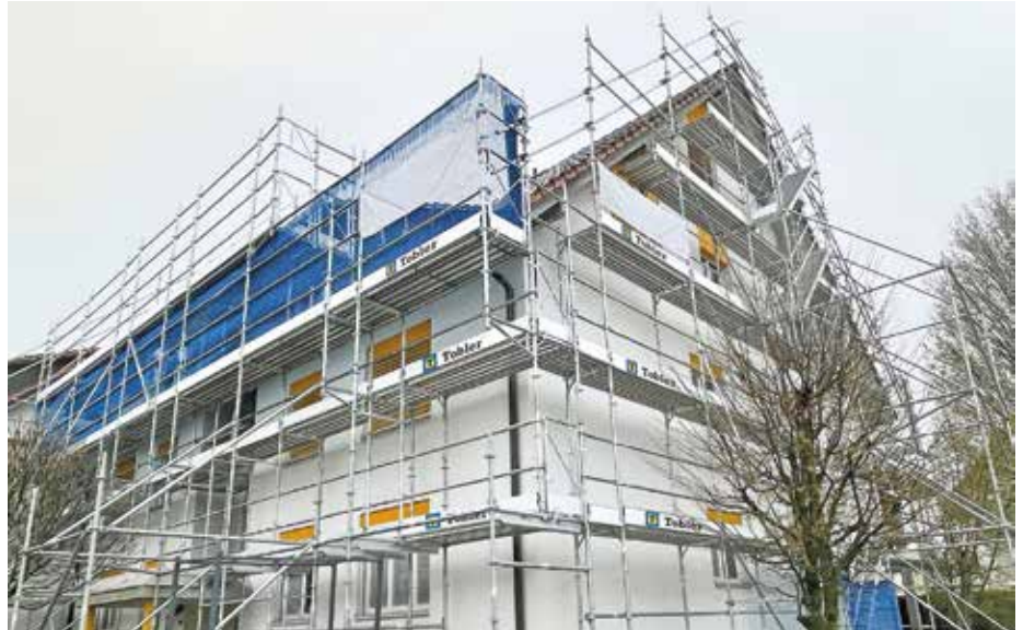
MATO 3 ist ein neuartiges Gerüstsystem und arbeitet mit einer Breite von 75 cm. Einzigartig sind die Beläge, mit denen sich ein spaltenfreier Gerüstbau realisieren lässt.
