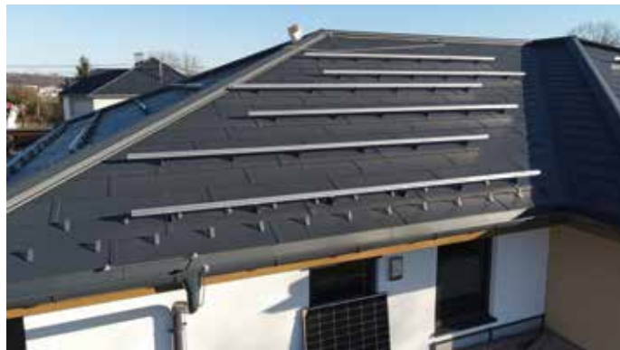
PV-Unterkonstruktionen bieten eine robuste Struktur und Verbindung zum Untergrund, die die Solarmodule sicher und stabil auf dem Dach oder dem Boden halten.
