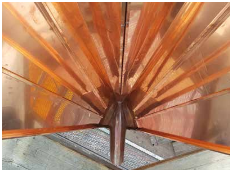
Wasserführung zwischen den Wimpergen zum Ausspeier.
