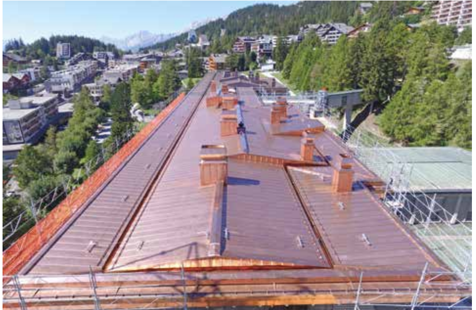
Das fertige Dach, mit unterschiedlicher Patina je nach Bewitterung vom Kupfer.
