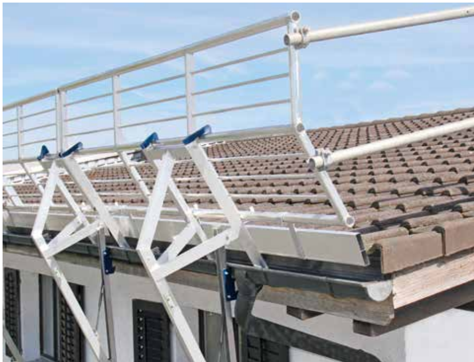
Eine Dachabsturz-sicherung mittels Integralkonsolen und einem Aufstieg über einen Treppenturm bietet gegenüber einem Fassadengerüst das Potenzial einer Einsparung von 50%.
