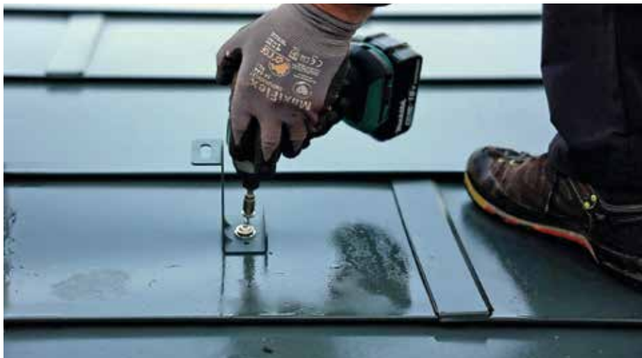
Der FIGO PV-Halter für Unterkonstruktionen wird auf der FIGO Dachplatte angebracht.
