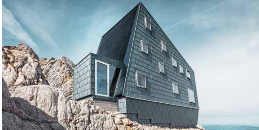
Neben der Basiswindlast ist auch die Lage des Objekts entscheidend, auch die Gebäudehöhe und die Dachform sind für die resultierende Windbelastung maßgeblich.
