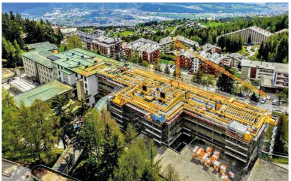
Abbruch und Bau vom neuen Dach, Abdichtung und Holzkonstruktion.
