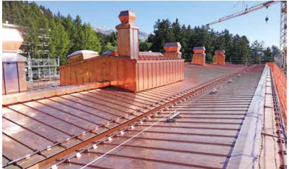
Fertige Doppelstehfalz-Dachdeckung mit den imposanten Dachaufbauten.
