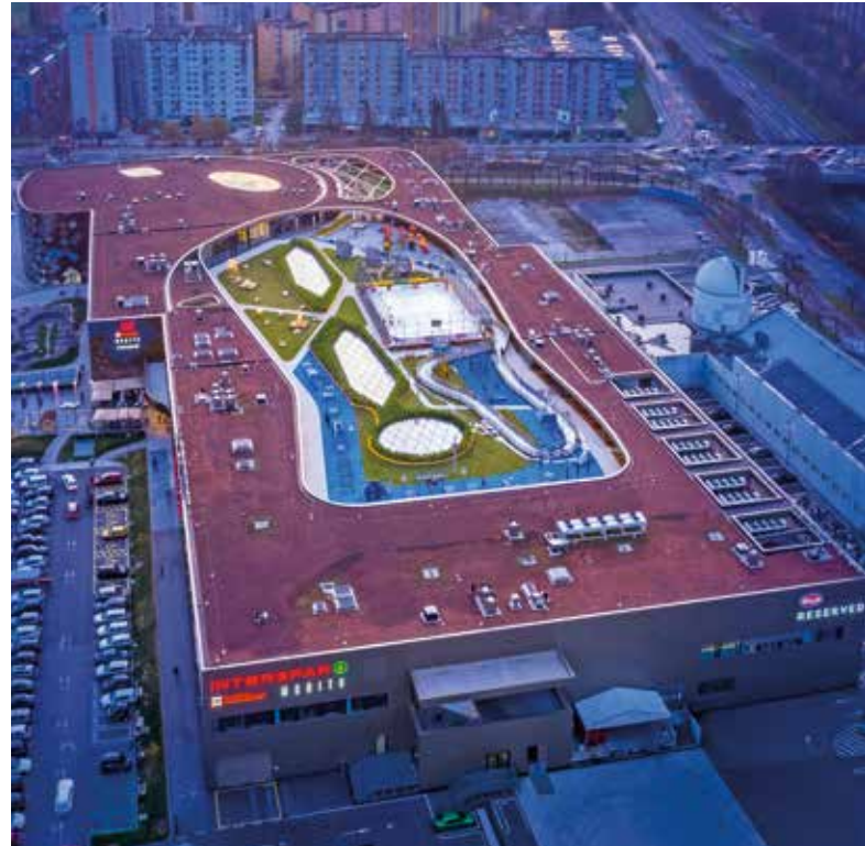
Auf dem Dach befindet sich eine 6.200 m 2 große Sport- und Erholungszone – ALEJA SKY. | Foto: © Janez Kotar
