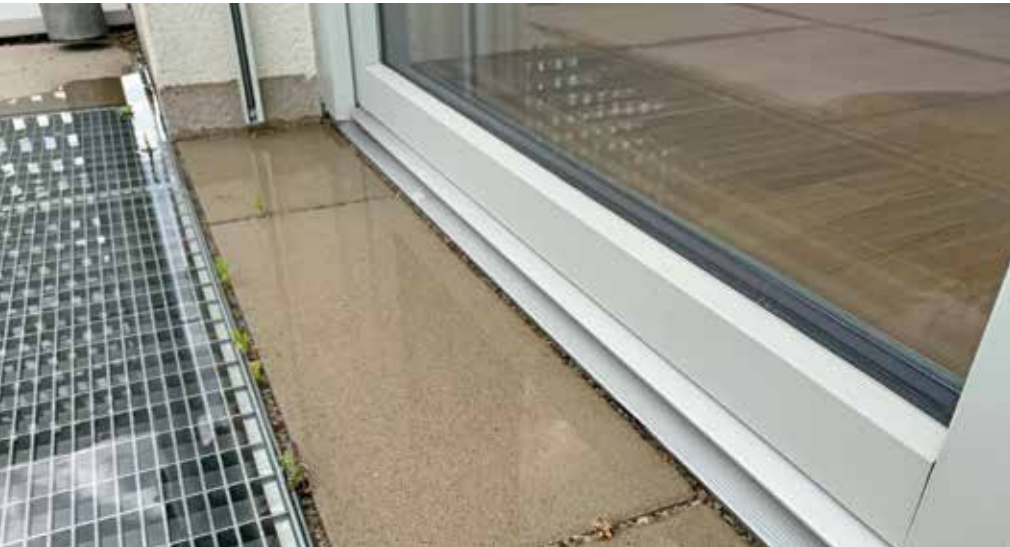
Im Bild: Aufstauendes Wasser bei Wasserbelastung
