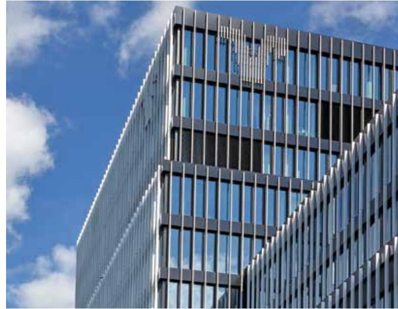
Der Außenbau mit bodentiefen Fenstern besitzt eine vorgehängte vertikale Lamellenstruktur aus eloxierten Aluminiumprofilen.
