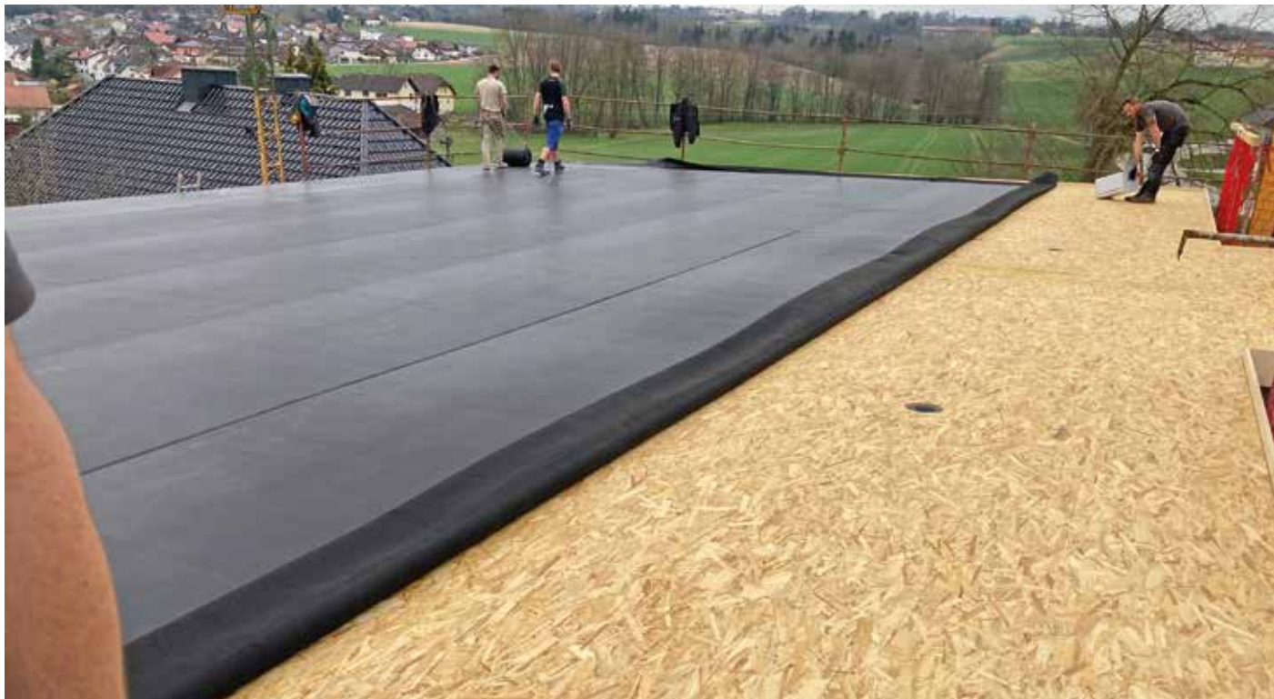
Die Verlegung von SuperSeal auf der Baustelle.
