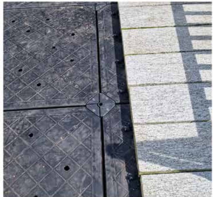
Femox VersiJack K Trägerplatte mit seitlicher Metallverstärkung Als Schutz vor Durchbruch bei möglichem Bruch von Plattenbelag. Konstruktion auf Femox VersiJack Stelzlagern.
