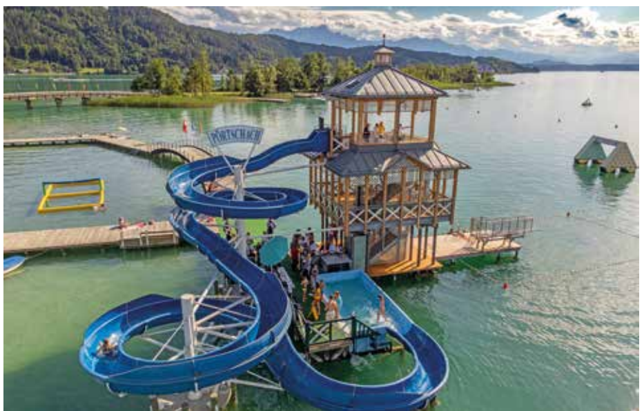
Die Dacheindeckung mittels DUOFALZ in Hellgrau, die eine Fläche von etwa 80 m 2 umfasst, sowie die Wandverkleidung von etwa 10 m 2 fügen sich perfekt in das Gesamtbild ein.
