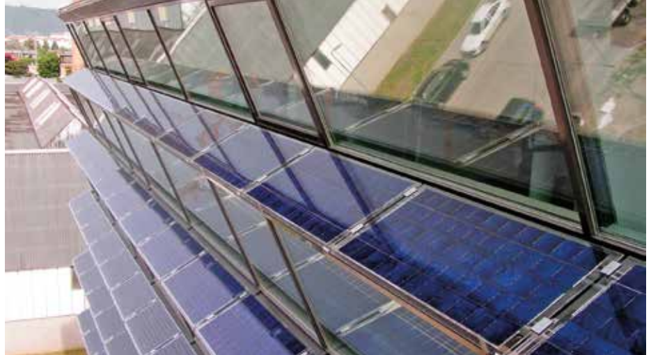
Der innovative Charakter des PV-Systems der Energybase besteht darin, dass die Module über neuentwickelte Patchfelder zu jeder beliebigen Kombination verschalten werden können. | Foto: © Solarwatt
