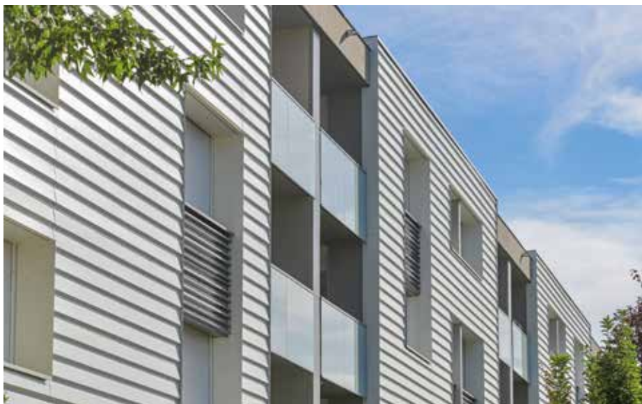
Bei der Résidence Maurice Thorez wurden die Stahllösungen von ArcelorMittal Construction, insbesondere die Océane®- und Eclectic®-Profile, eingesetzt, um das Gebäude zu renovieren und ihm ein modernes, unverwechselbares Aussehen zu verleihen.
