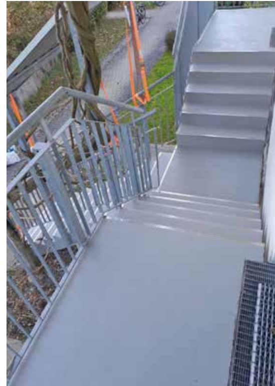
Die Stiegen sind nun langfristig dicht und dank der Rutschklasse R11 für die Bewohner sicher begehbar. | Fotos: Triflex (4)
