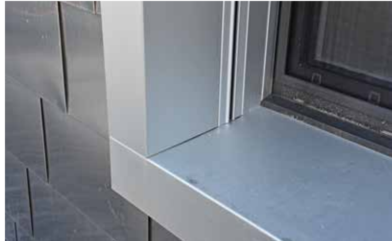
Perfekte An- und Abschlusssdetails, Storeschienen in Leibungen integriert, saubere Luftöffnungen unter der Fensterbank.
