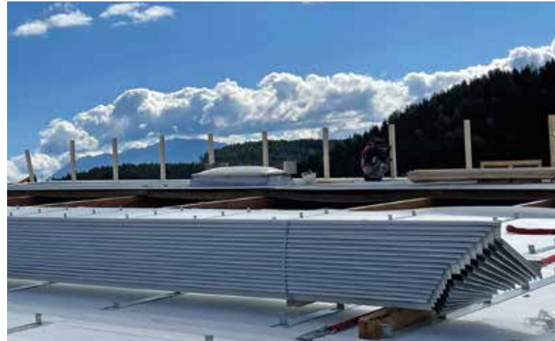
Das Domitec®-Dach wurde zeitsparend und durchdringungsfrei mittels werkseitig vormontierter Haltern befestigt. Foto: Eder Blechbau
