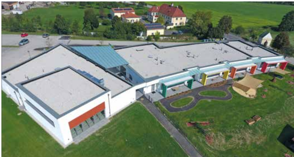
Das Amstettner Unternehmen Haberhauer Dachzentrum setzt bei seinen Flachdach-Projekten auf die digitale Aufmaßerstellung und Projektabwicklung mit C|DAS von COVERiT. Foto: Haberhauer Dachzentrum
