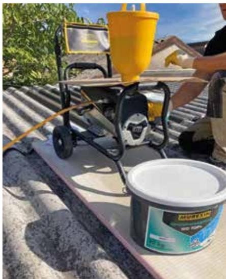
Ein Dach mit Wellplatten wurde mit der Murexin Spezialversiegelung WD Top+ im Airlessverfahren in kürzester Zeit aufgefrischt.
