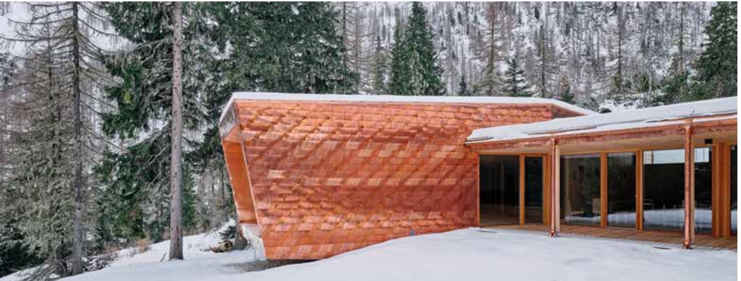
*Die Fraganter Selbstversorgerhütte setzt architektonische Akzente: Der auskragende Anbau mit seiner stollenartigen Öffnung ist mit ca. 700 handgefertigten Kupferschindeln verkleidet, die einen sichtbaren Bezug zur Vergangenheit herstellen. | Fotos: © Schreyer David (3)*
