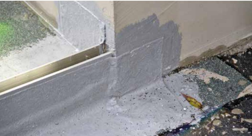
*Völlig untauglicher Abdichtungsanschluss an das WDVS im Übergang zum Glasschuh.*
