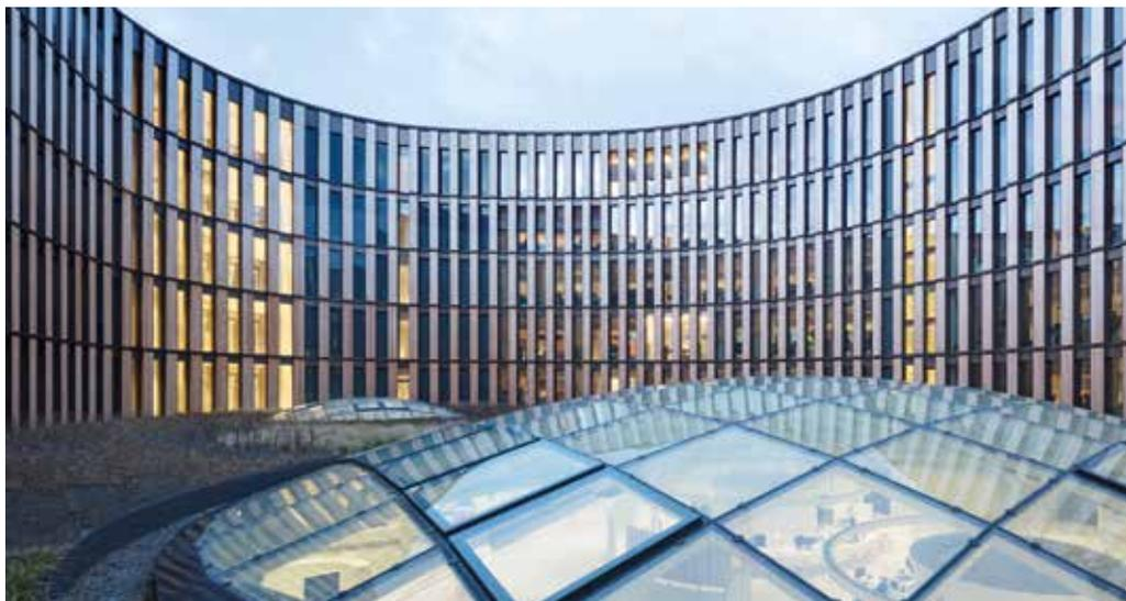
*Die komplexe Fassade ist integraler Bestandteil des Gesamtkonzepts und zeigt die hohen energetischen Ansprüche des Gebäudes. Es handelt sich um eine spezielle Art einer Lärchenholzfassade, welche sich aus versetzt angeordneten, senkrecht auskragenden Modulen mit Photovoltaikzellen, samt hochwertiger Wärmedämmung, zusammensetzt.*
