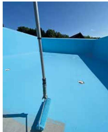
Die Spezialversiegelung WD Top+ schützt im Pool die darunterliegende Spezialabdichtung WD-1K. | Fotos: © Murexin GmbH (2)
