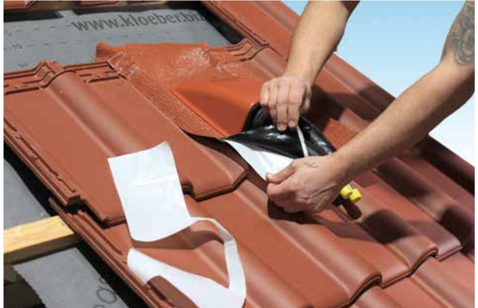
*Durch EISEDICHT®-AufdachDICHT Manschetten vermeiden Sie das Eindringen von Feuchte und Wasser in die Dachkonstruktion.*
