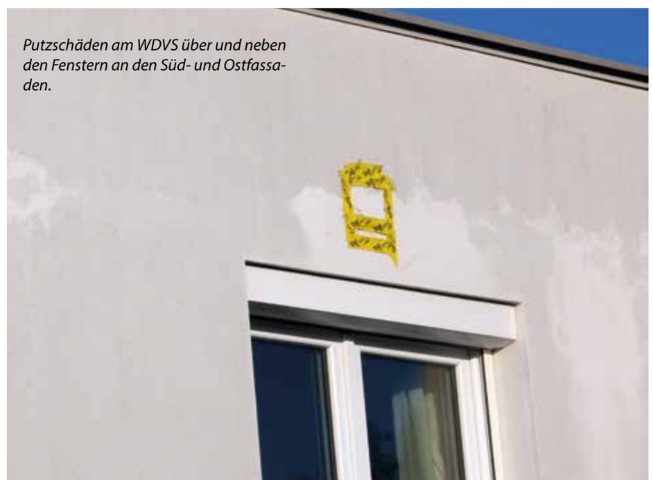
Putzschäden am WDVS über und neben den Fenstern an den Süd- und Ostfassaden.
